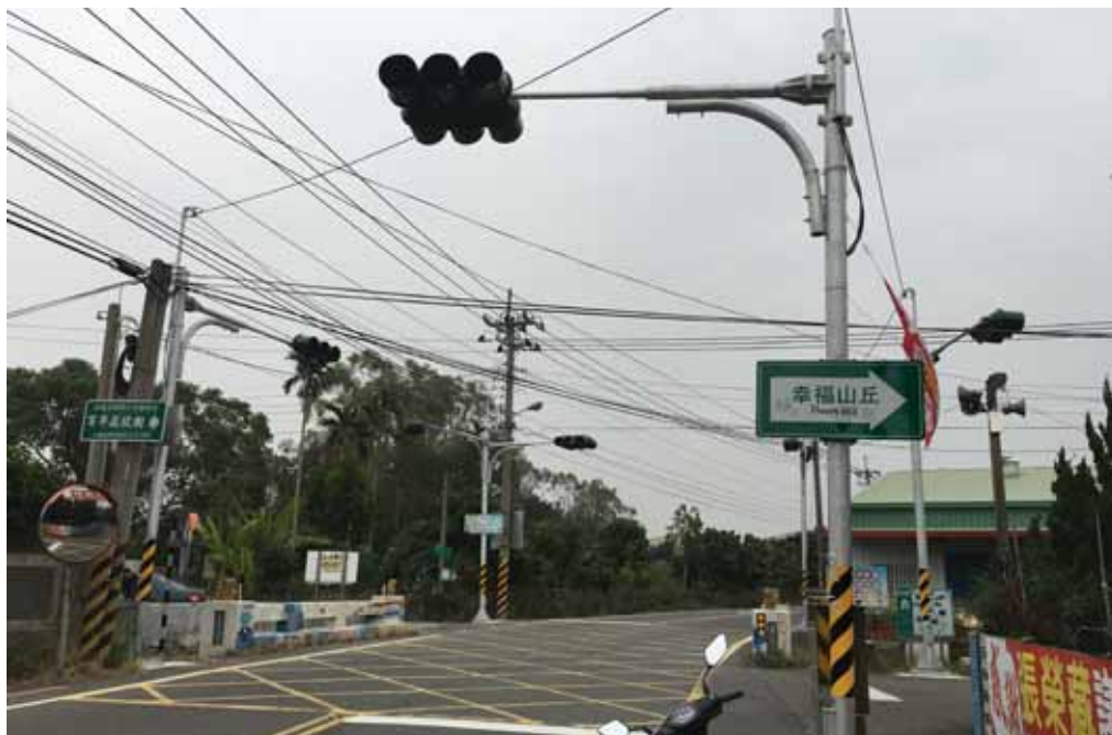
圖 3.3.2-1 半觸動號誌實作路口現況
