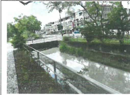
道將圳渠道現況
