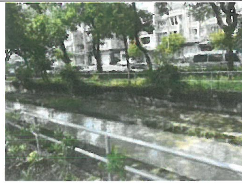
道將圳渠道現況
