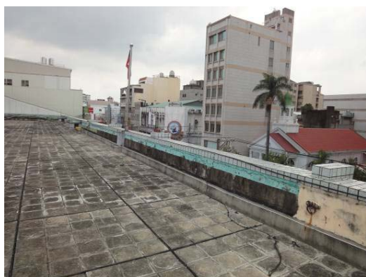
地坪與女兒牆現況
