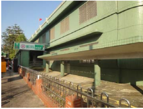
圖 2-17 鋼筋混凝土停車棚 (本計畫拍攝)
