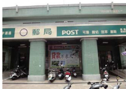
原電鐘已拆除
