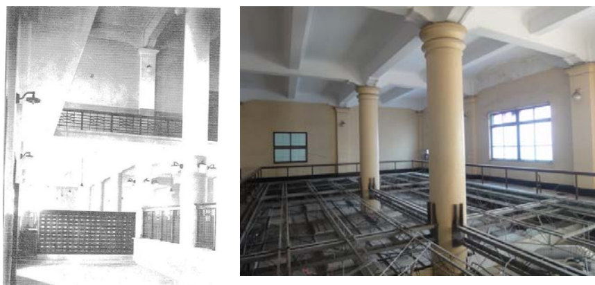
圖 2-69 樓上空中庭過去與現況對照
