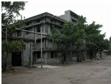
照片 27 舊酒廠園區內部 2
