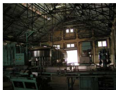
照片 28 舊酒廠園區內部 3
