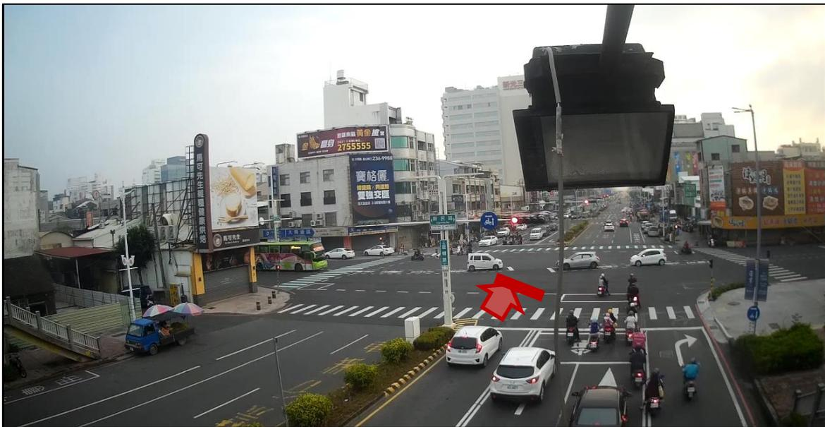
圖 7.3-1 左轉專用道停止線前移(增設左彎停等區)示意圖
