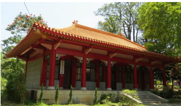
【圖 5-2-32】孔廟崇倫堂現況
