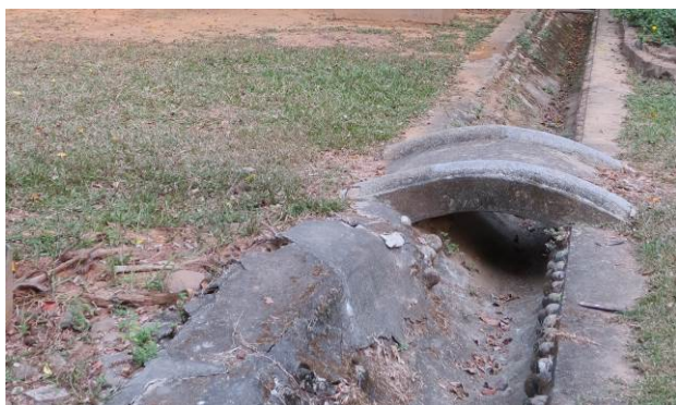
【圖 5-2-28】參道外緣明溝拱橋通道
