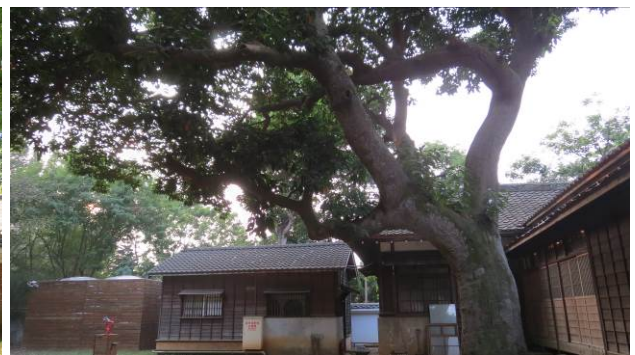
【圖 5-2-27】後院錫蘭橄欖主幹有腐朽跡象宜再檢測防護
