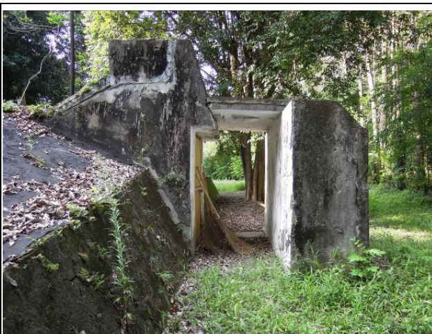
【圖 4-3-17】地下空襲指揮室入口之一
