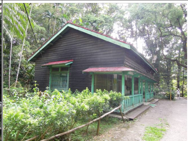
【圖 4-3-14】樹木園管理室為木造雨淋板建物，兩側無往前突出建物，與 1938 年配置圖不同
