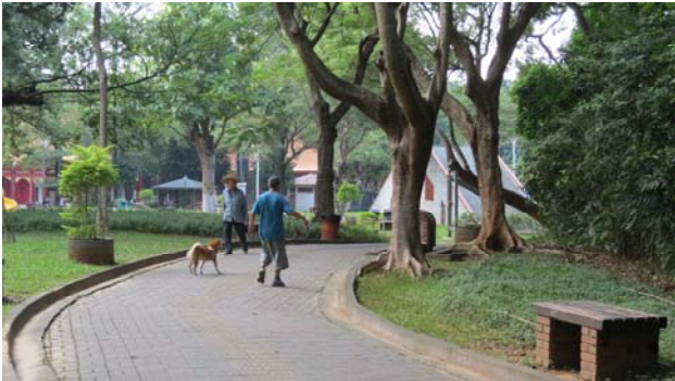
【圖 2-2-11】嘉義公園主要動線鋪設透水磚，路寬多為 3.6 公尺
