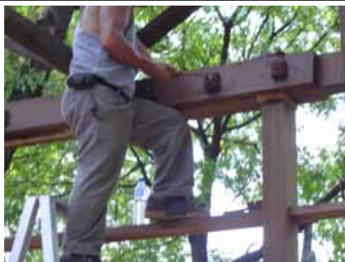
相 4-170 手編工廠屋架修補與局部抽換
