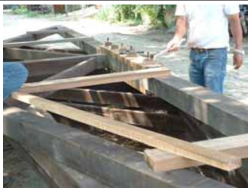
相 4-172 手編工廠三角構架整修抽換
