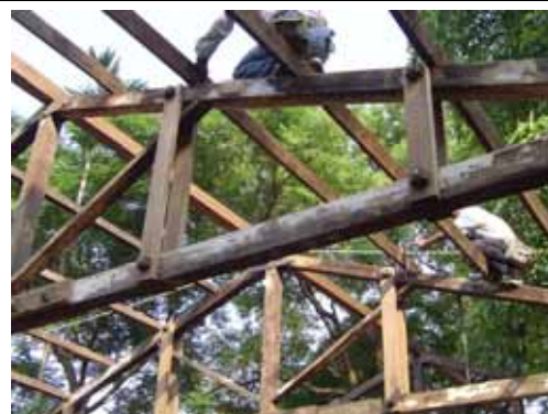
相 4-173 手編工廠屋架桁木抽換
