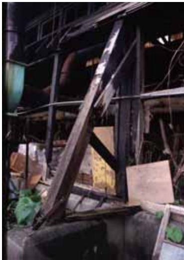
相2-51 構件受火害後破壞狀況
