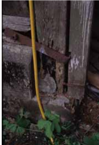
相 2-49 柱材局部腐朽
