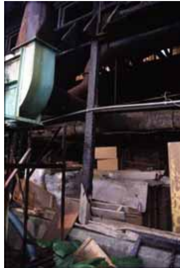
相2-52 構件受火害後破壞狀況
