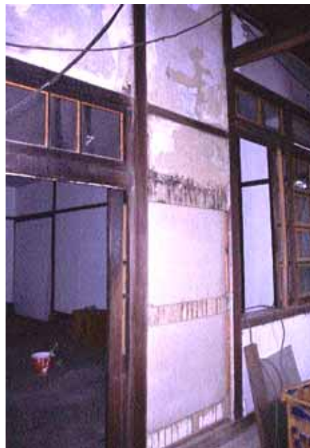
相 2-32 編竹夾泥牆體破壞
