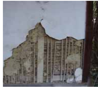
相 2-44 編竹夾泥牆體破壞
