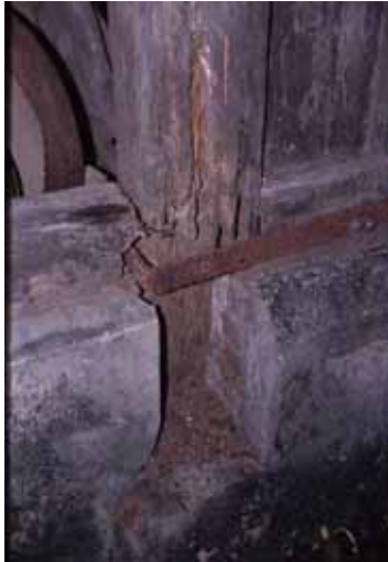
相 2-48 柱材局部腐朽
