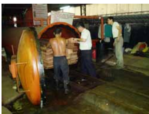
相 4-194 木料 ACQ 防腐處理
