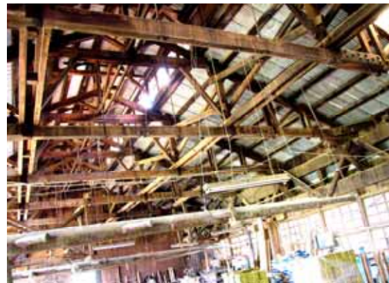
相1-1 機具工廠副同柱式屋架
