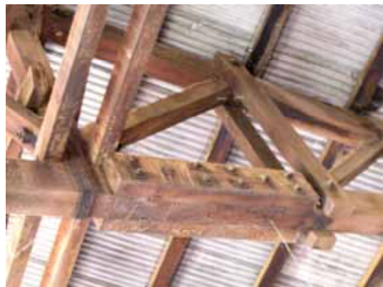
相1-2 第一製材場中水平大樑搭接
