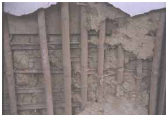
相 1-3 編竹夾泥牆牆體內部
