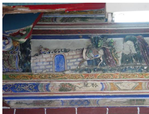
〔照片 2-3-29〕水車堵之剪黏裝飾物
