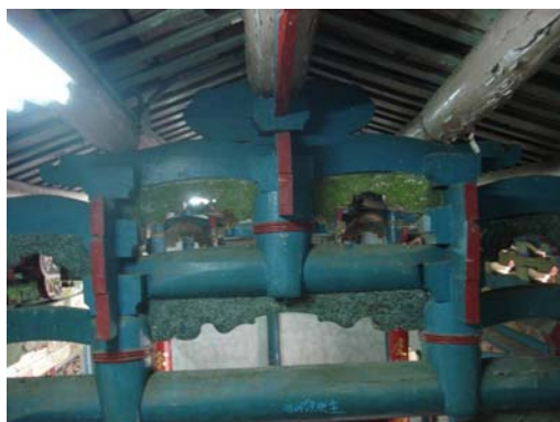
〔照片 2-3-14〕疊斗屋架面次間一側未施木雕及彩繪
