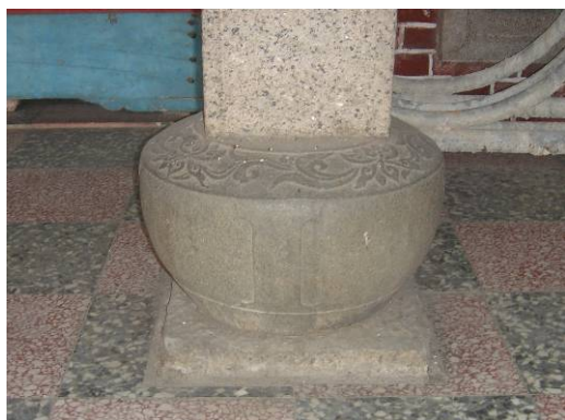
〔照片 2-3-26〕石造柱礎立面浮雕
