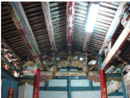
〔照片 2-3-10〕明間面內五架式疊斗架棟
