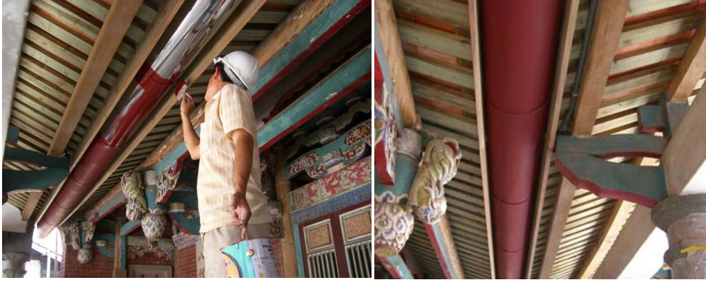
〔照片5-1-7〕排水槽(金屬質)，封簷板作法 〔照片5-1-8〕排水槽、封簷板作法改善 以油漆上色改善
