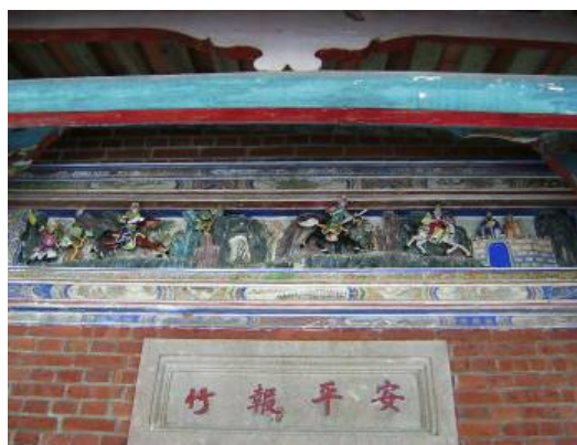
〔照片5-1-14〕缺失改善完成狀況
