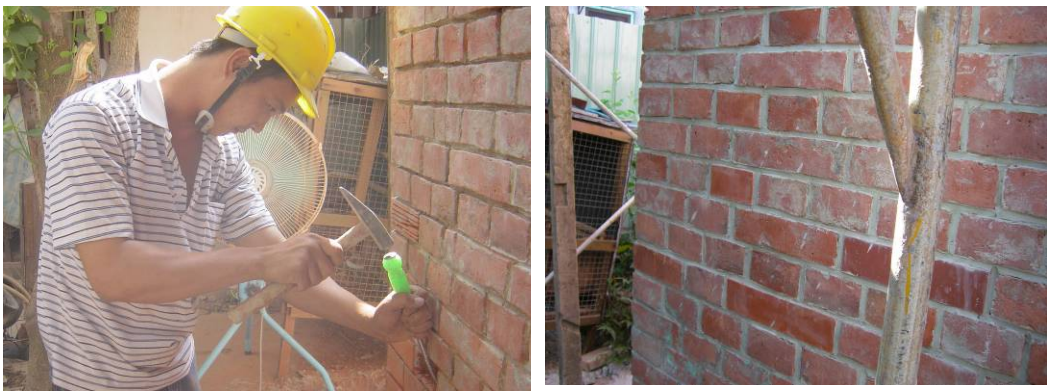
〔照片5-1-9〕清水磚牆牆面小心清理
