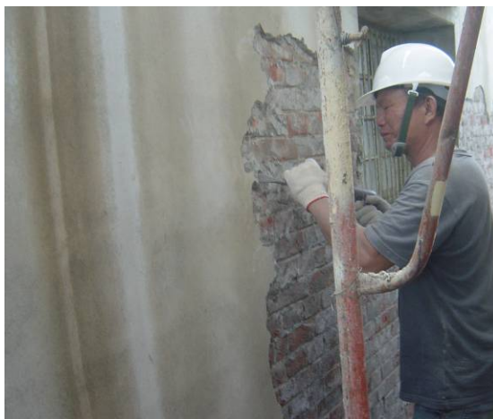
〔照片5-1-2〕敲除以不損毀原構件為原則。
