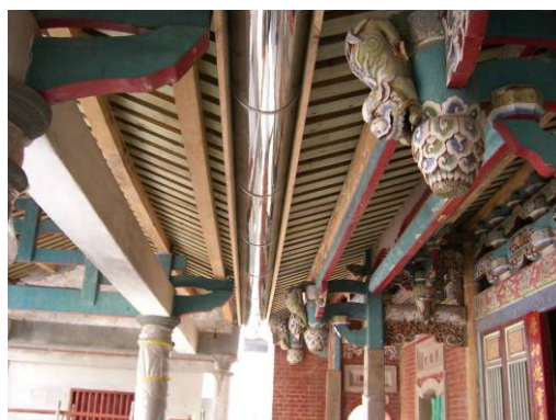
〔照片5-1-6〕正廳之前坡與拜亭後坡屋面銜接處的不甚恰當
