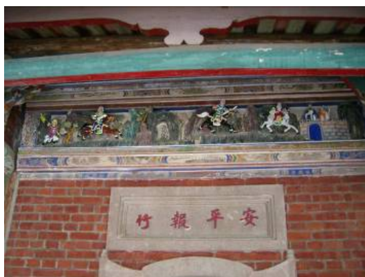
〔照片5-1-13〕修補之剪黏碗片釉色太鮮亮，似與原有物件不搭配
