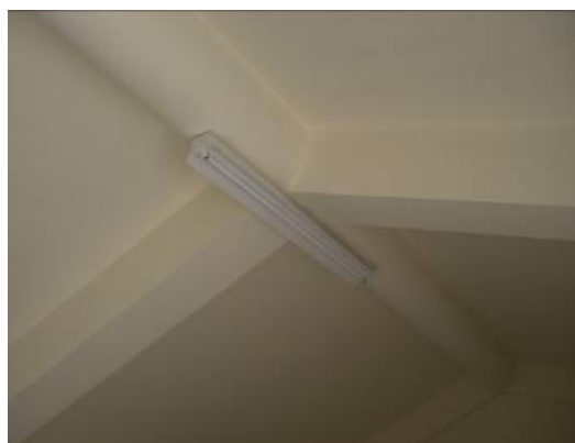
〔照片5-1-12〕缺失修補完成
