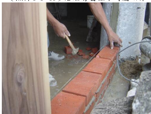
〔照片4-1-43〕右廂房磚牆施工砌作
