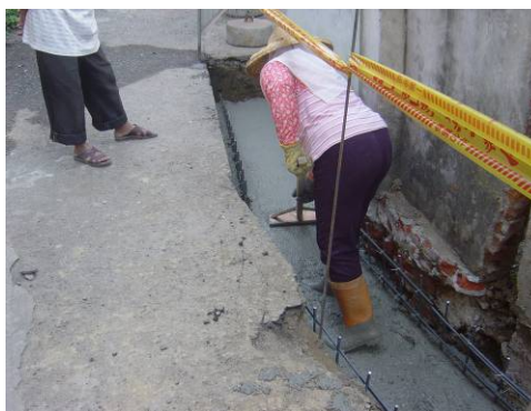
〔照片4-1-75〕溝底RC打底
