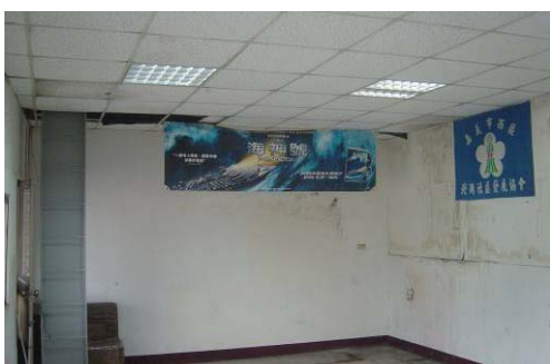
〔照片4-1-1〕左廂房修復前內部形貌
