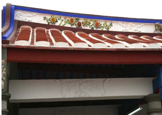
〔照片4-3-5〕拜亭右次間屋脊與RC大梁灰泥泥塑
