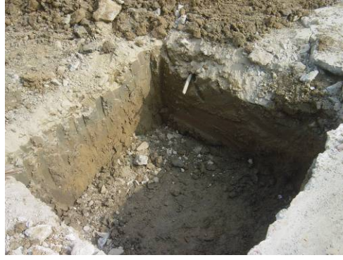
〔照片4-1-10〕基礎土方開挖
