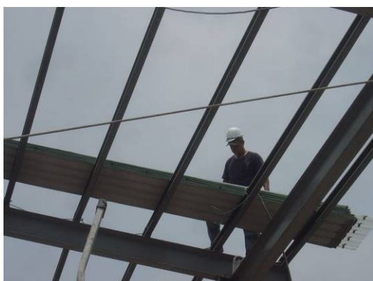
〔照片4-2-11〕人工拆除屋面鋼板
