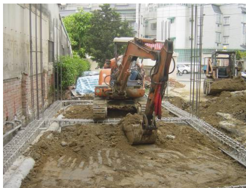
〔照片4-1-16〕地坪土方挖填運棄夯實
