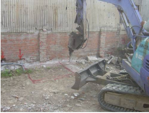
〔照片4-1-7〕左廂房基礎開挖
