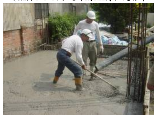
〔照片4-1-21〕3500psi預拌混凝土搗築
