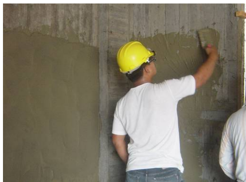
〔照片4-1-45〕左廂房壁面水泥沙漿打底
