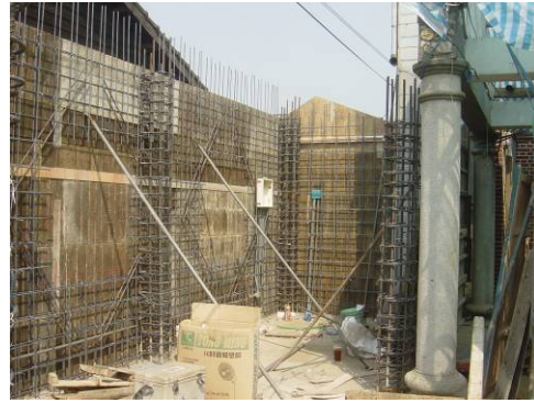
〔照片4-1-24〕牆體鋼筋綁立2
