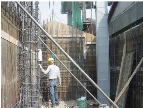
〔照片4-1-25〕右廂房牆體鋼筋綁立完成
