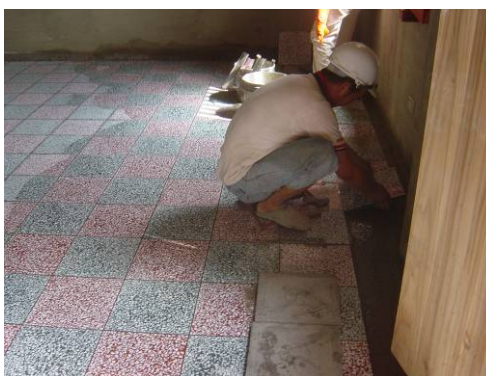
〔照片4-1-58〕由中間往牆邊鋪設
