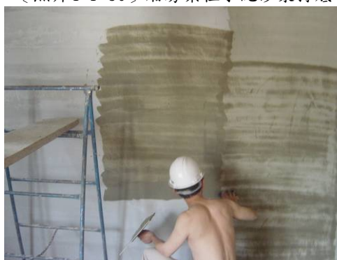
〔照片4-1-52〕 油漆前牆面披土打底
