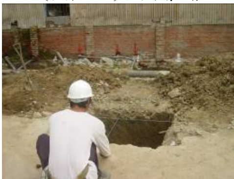
〔照片4-1-6〕基礎放樣
