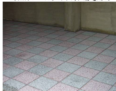
〔照片4-1-60〕鋪設完成
