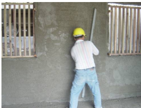
〔照片4-1-46〕壁面沙漿打底刮毛
