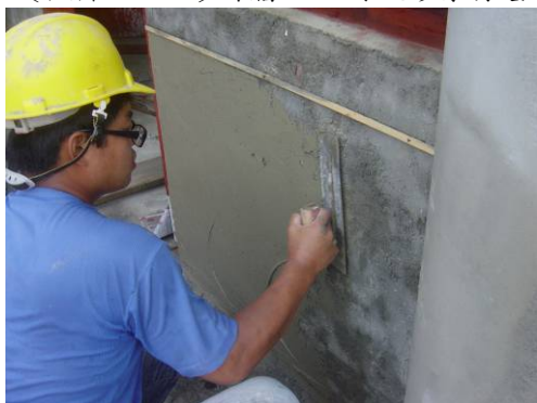
〔照片4-1-63〕釘壓條，洗石子面層塗抹
