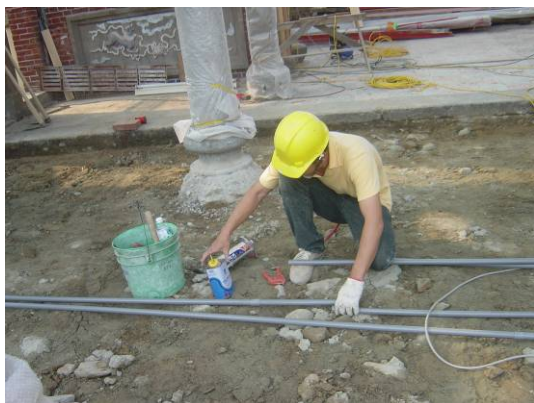
〔照片4-2-15〕左右廂與拜亭電氣管路施工
