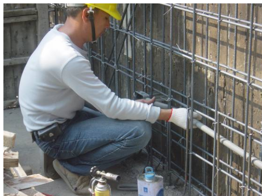
〔照片4-2-16〕電氣設備及管線工程
