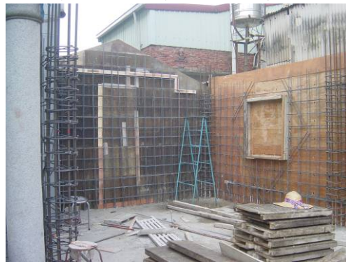
〔照片4-1-26〕左廂房牆體鋼筋綁立完成
