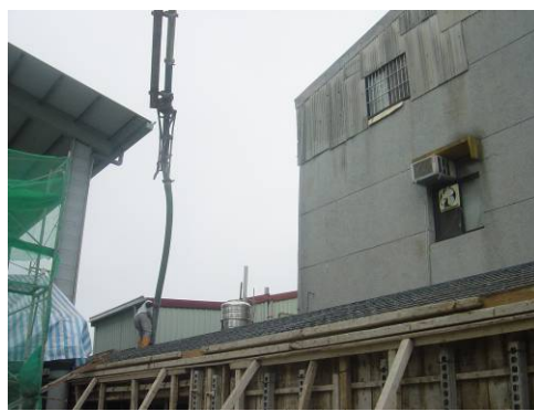
〔照片4-1-36〕3500psi預拌混凝土搗築
