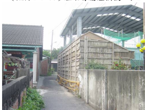
〔照片4-1-32〕右廂房牆體模板工程2
