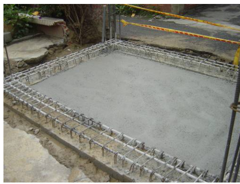
〔照片4-1-18〕室內地坪混凝土打底
