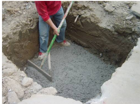
〔照片4-1-12〕2000PSI混凝土地基打底施作
