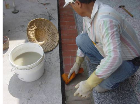
〔照片4-1-83〕溝底鋪設30*30cm清水尺磚
