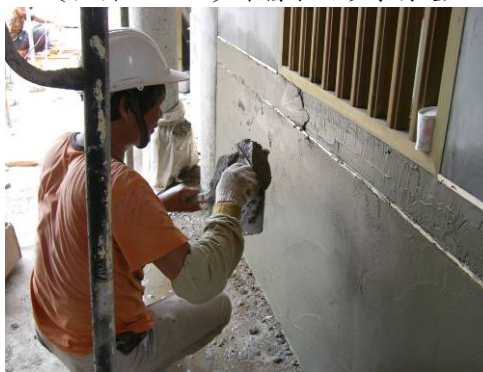
〔照片4-1-64〕洗石子面層塗刷
