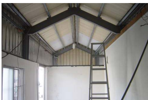
〔照片4-1-2〕右廂房修復前內部形貌
