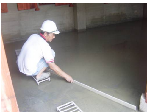
〔照片4-1-57〕磨石子地磚施作前打底
