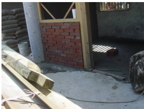
〔照片4-1-42〕右廂房磚牆施工
