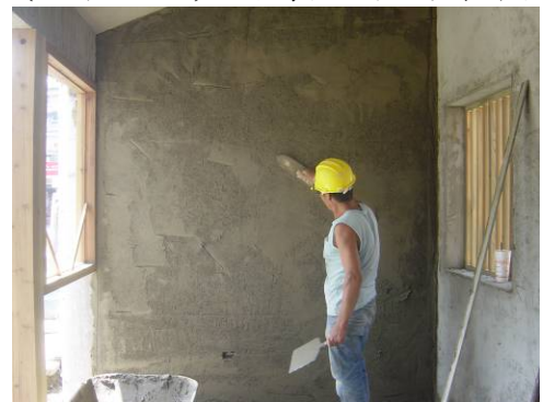
〔照片4-1-47〕右廂房壁面水泥沙漿打底
