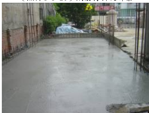
〔照片4-1-22〕3500psi預拌混凝土搗築
