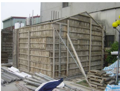
〔照片4-1-29〕左廂房牆體模板工程1
