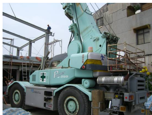
〔照片4-2-12〕吊車配合吊離
