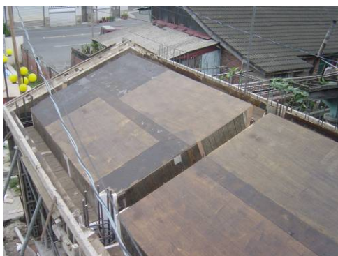
〔照片4-1-33〕屋面模板工程
