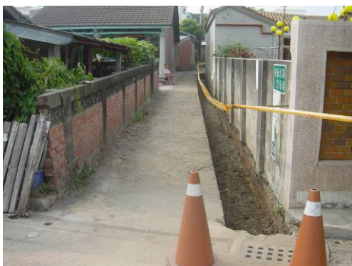
〔照片4-1-74〕建築周邊排水溝挖掘
