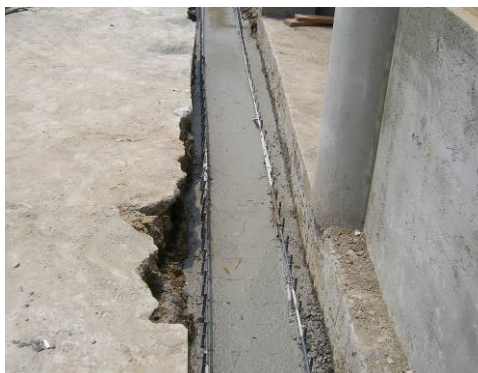
〔照片4-1-79〕溝底RC打底鋪設
