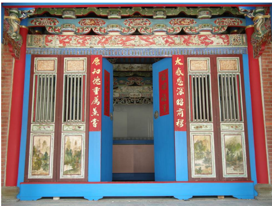
〔照片4-3-1〕管理委員會委託修復完成之正廳正面與隔扇門彩繪
