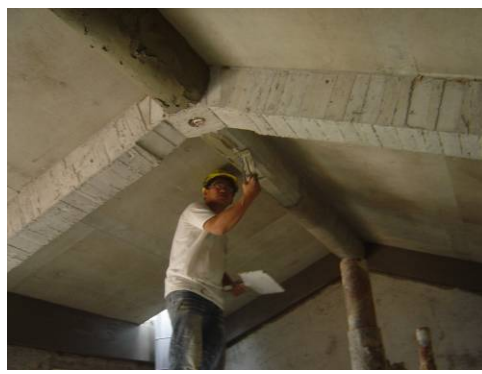
〔照片4-1-50〕 廂房梁柱水泥沙漿打底
