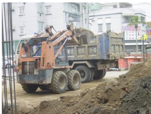
〔照片4-1-17〕土方挖填運棄
