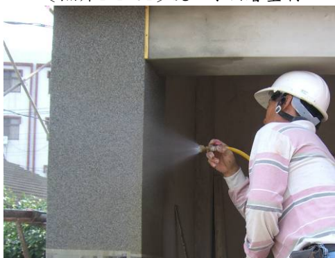
〔照片4-1-66〕細石面露出與完成
