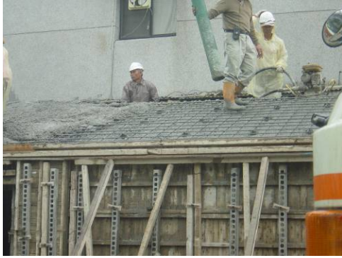
〔照片4-1-37〕3500psi預拌混凝土搗築
