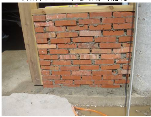
〔照片4-1-44〕右廂房磚牆施工
