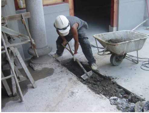
〔照片4-1-82〕拜亭前排水溝挖掘
