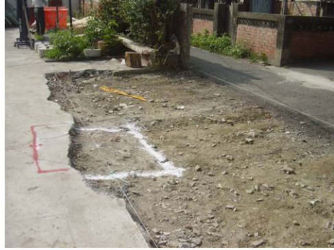
〔照片4-1-8〕右廂房基礎開挖
