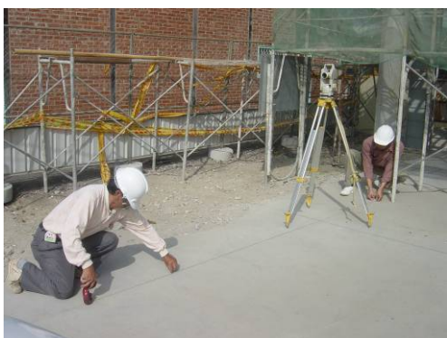
〔照片4-1-3〕放樣測量定位
