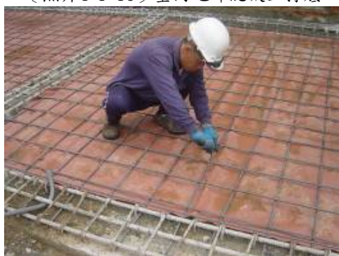
〔照片4-1-20〕鋼筋材料及綁紮
