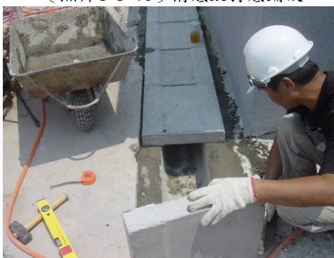
〔照片4-1-81〕安裝水泥溝蓋板
