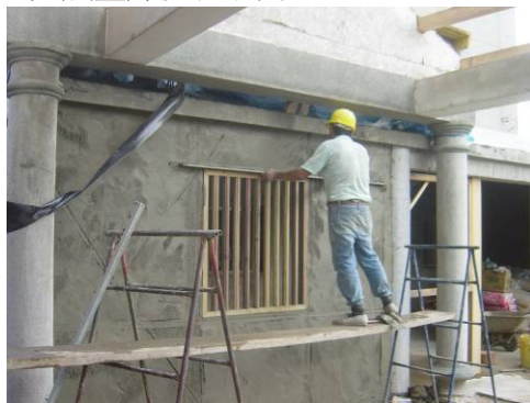
〔照片4-1-62〕外牆水泥沙漿打底
