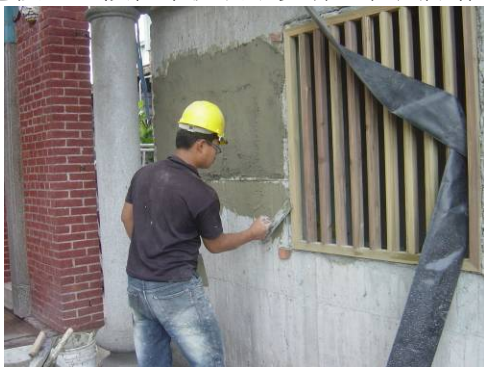
〔照片4-1-61〕外牆1:2 水泥沙漿打底
