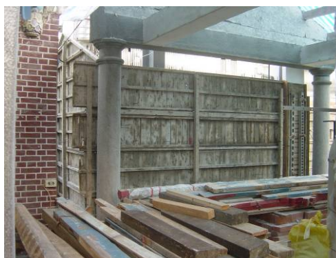
〔照片4-1-30〕左廂房牆體模板工程2
