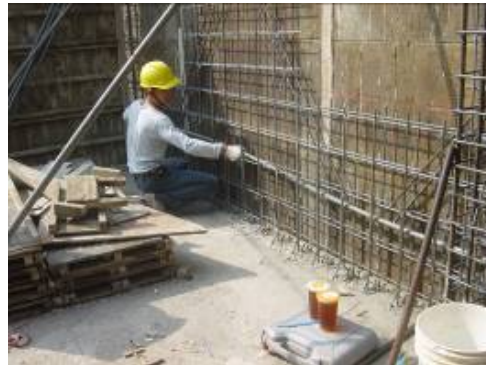
〔照片4-1-28〕水電管線埋設2
