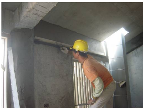
〔照片4-1-49〕 廂房梁柱水泥沙漿打底
