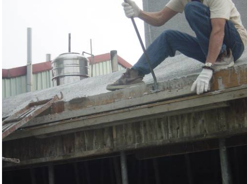
〔照片4-1-39〕模板拆除
