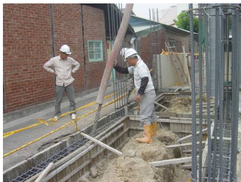
〔照片4-1-15〕RC梁柱鋼筋組立與澆灌水泥
