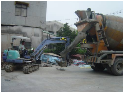
〔照片4-1-11〕地基打底施作
