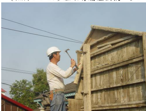
〔照片4-1-31〕右廂房牆體模板工程1
