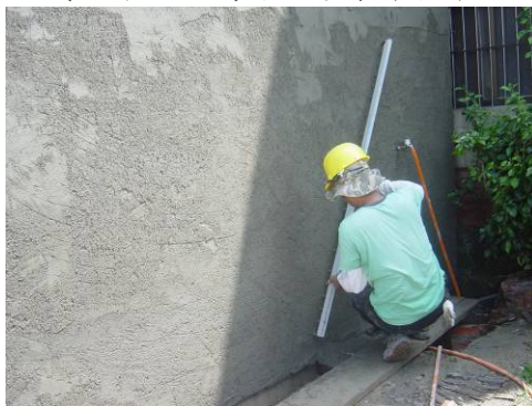
〔照片4-1-48〕左廂房外牆水泥沙漿打底
