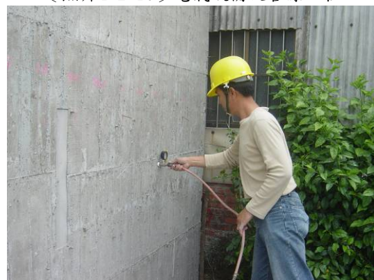
〔照片4-2-18〕水電工程. 水管壓力測試
