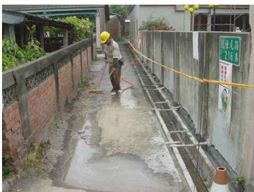
〔照片4-1-76〕排水溝RC板模灌漿
