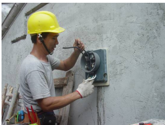
〔照片4-2-19〕電錶移位施工
