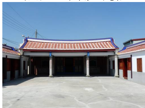
〔照片4-1-73〕地坪修補完成
