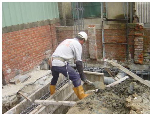
〔照片4-1-14〕地坪土方挖填
