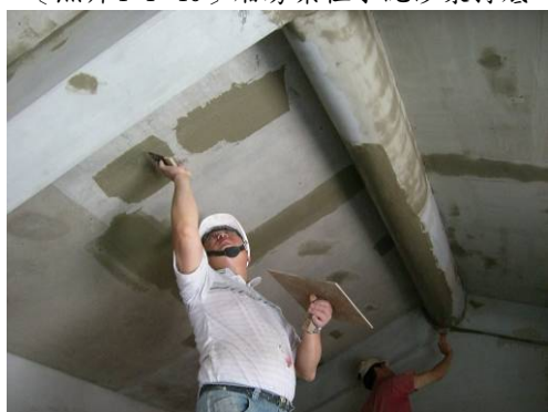
〔照片4-1-51〕 油漆前內屋面披土打底
