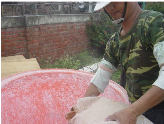
〔照片4-2-1〕養灰桶與置入石灰粉
