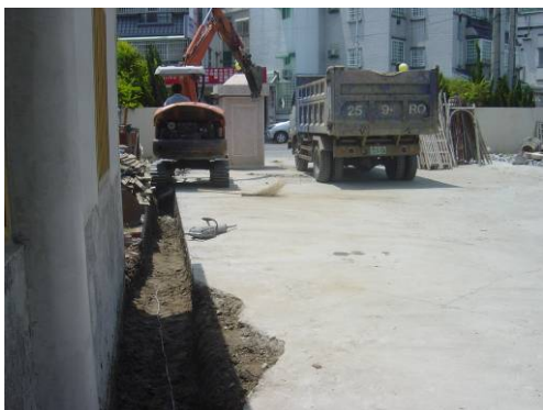
〔照片4-1-78〕內埕排水溝開挖
