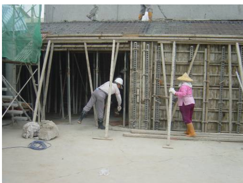
〔照片4-1-35〕3500psi預拌混凝土搗築
