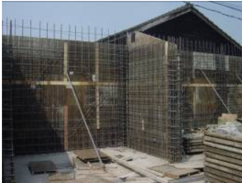
〔照片4-1-23〕牆體鋼筋綁立1
