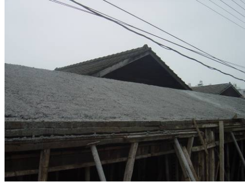
〔照片4-1-38〕混凝土搗築完成
