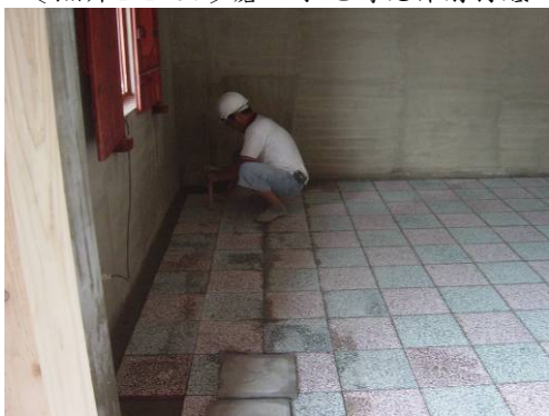
〔照片4-1-59〕由中間往牆邊鋪設
