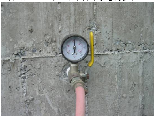
〔照片4-2-17〕水管試壓
