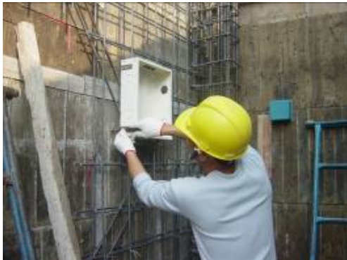
〔照片4-1-27〕水電管線埋設1
