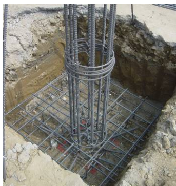
〔照片4-1-13〕基礎RC配筋
