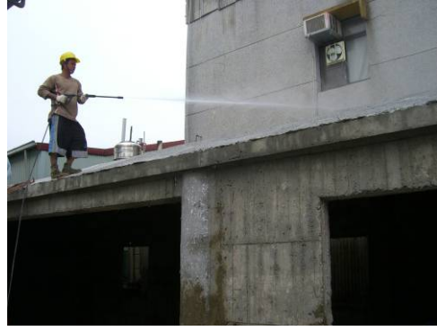
〔照片4-1-40〕拆模後養護
