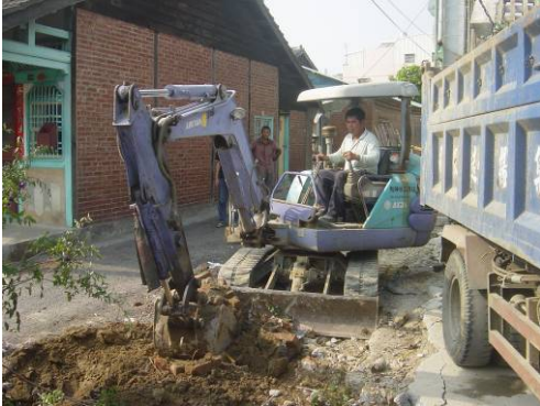
〔照片4-1-9〕右廂房基礎開挖
