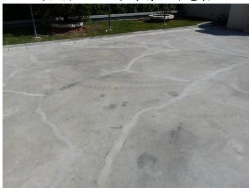
〔照片4-1-72〕地坪龜裂水泥沙漿修補
