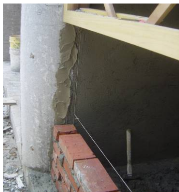
〔照片4-1-41〕右廂房窗框下磚牆砌作
