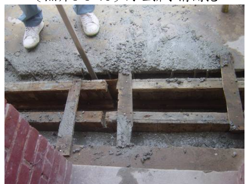
〔照片4-1-80〕排水溝RC板模灌漿
