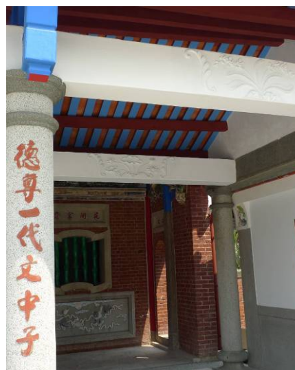
〔照片4-3-6〕拜亭左次間RC大梁灰泥泥塑
