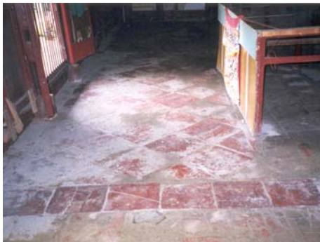
圖 23 正廳地坪現況
