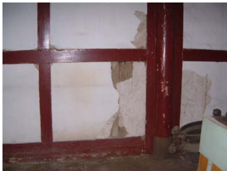
圖 22 編竹夾泥牆表面白灰漿粉刷
