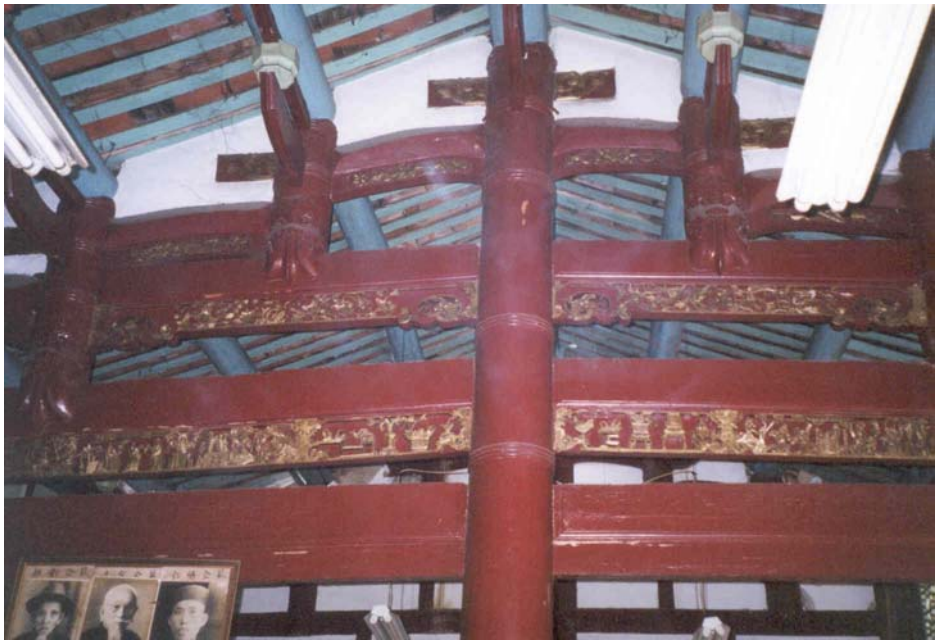
正廳大木構架（左側）
