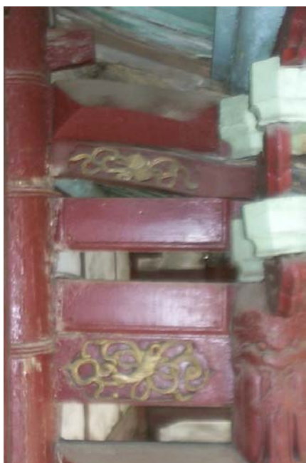
脊桁、三架桁間構件
