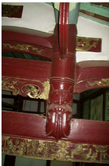
五架桁童柱
