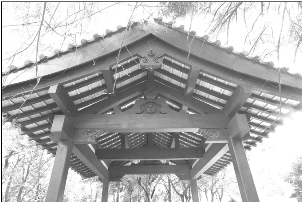
圖 75 手水舎屋架為檜木製的「和式切妻小屋組」
