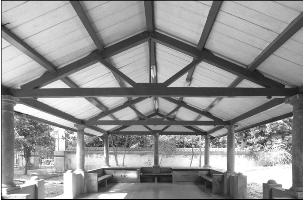
圖 74 休憩所(參集所) 屋架裸露且中央棟束採用鐵棒為本參集所的特色
