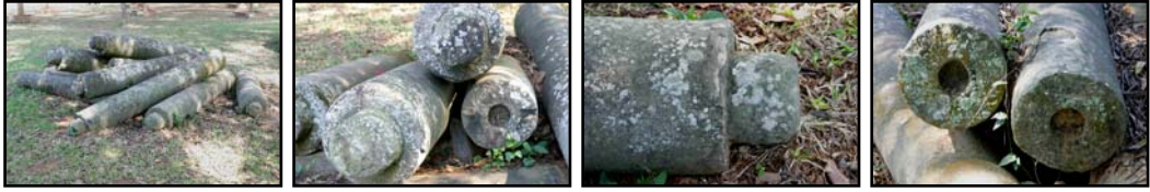
圖 84~87 堆置在休憩所旁的石構件共 12 件樺頭樺槽完整
