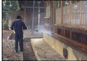
圖 94 地坪噴塗處理
