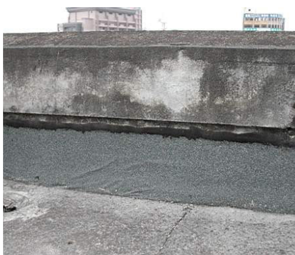
【圖 4-9-1】101R 的屋頂與防水層
