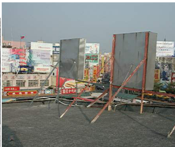
【圖 4-9-2】「嘉義車站」的看板固定在廣間的屋頂
