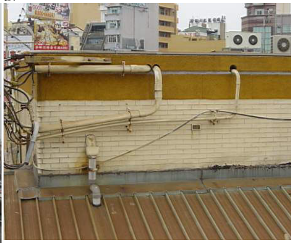
【圖 4-9-12】111R 女兒牆因管線配置而被貫穿
