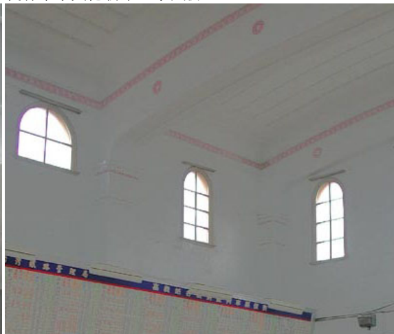
【圖 4-3-4】105R 鋼骨鋼筋混凝土梁側面紋樣現況
