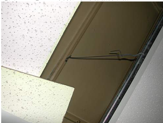
【圖 4-8-28】102R 新的輕鋼架天花吊掛在舊有天花的木作桁條上
