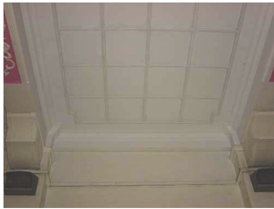
【圖 4-8-9】101R 介於柱編號 5 和 6 間的天花有油漆重新塗抹，且較其他地方髒的情形
