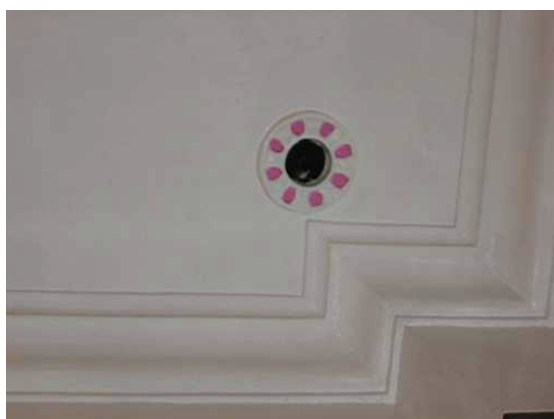
【圖 4-8-18】110R 的天花通氣孔與線腳現況
