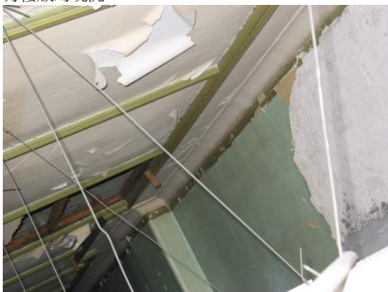
【圖 4-8-32】107R 舊有天花桁條與線腳
