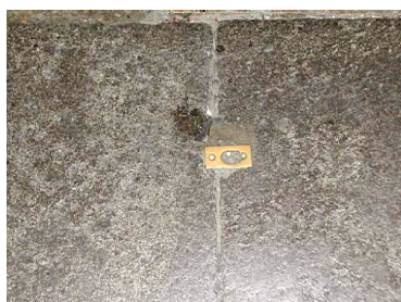
【圖 4-7-37】106-D2 地坪石材與固定 門扇五金痕跡
