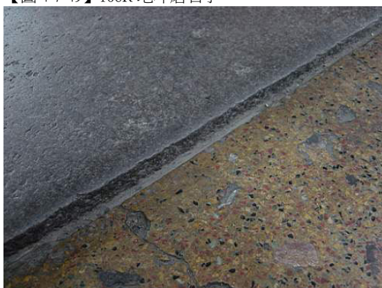
【圖 4-7-51】106R 磨石子與出入口地面石材的轉接縫
