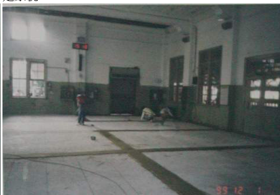
【圖 4-7-14】1999（民國 88）年參等待合室地板敲除重鋪（1999，〈嘉義站容整修工程〉）
