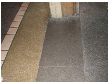
【圖 4-7-19】01R 面對剪票出口的門洞地坪石材 (101-D1)
