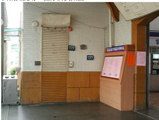
【圖 4-12-44】103R 的門扇改修成鐵捲門
