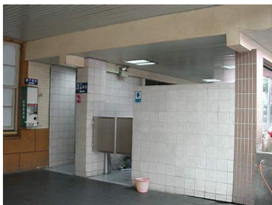
【圖 4-12-30】廁所南側入口現況
