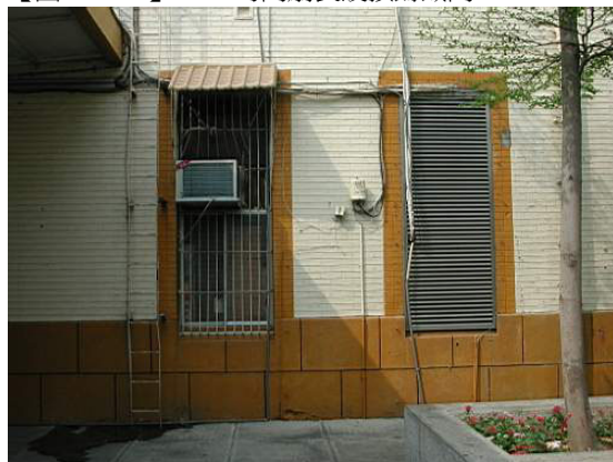
【圖 4-12-47】102R 和 103R 的窗扇從室內封住並從室外安裝鐵窗
