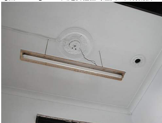
【圖 4-12-16】111R 固定於原燈座上的日光燈管
