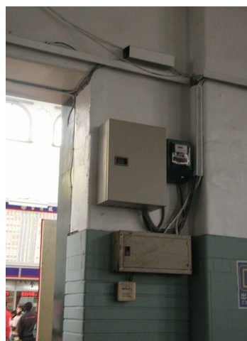
【圖 4-12-1】雜亂的水電管線，柱位旁的水管是供應下方空調設備而設置的，而嘉義火車站的公共空間就有十多個，另外梁下約 80 公分的位置還有電纜盒線
