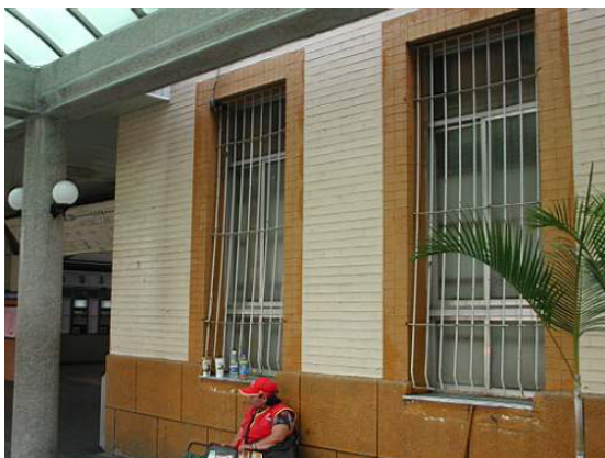
【圖 4-12-40】115R 和 108R 窗洞以從室內封住，室外則安裝了鐵窗
