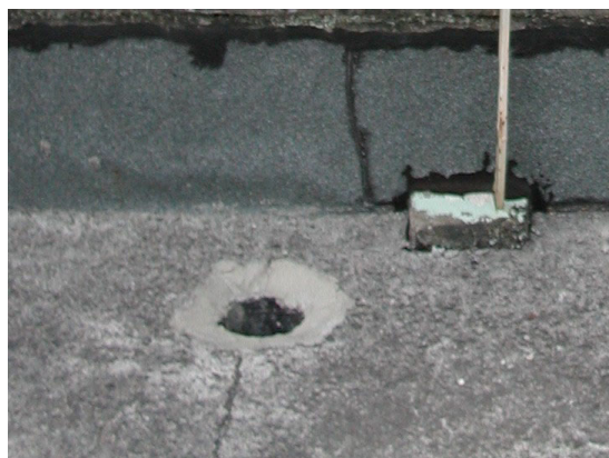
【圖 4-12-29】113R 屋頂北側設備排氣孔現況
