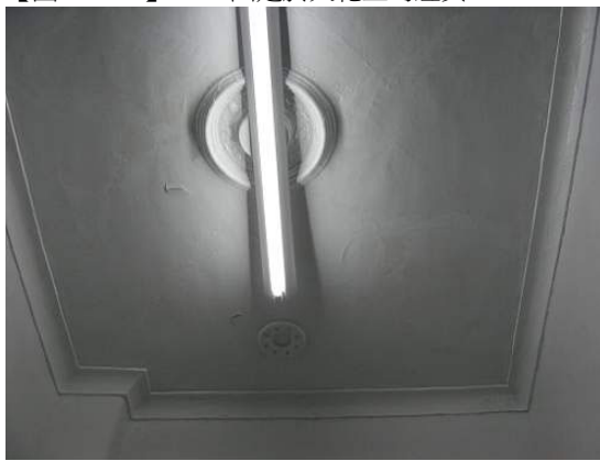
【圖 4-12-17】112R 固定於原燈座上的日光燈管
