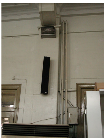
【圖 4-12-1】雜亂的水電管線，柱位旁的水管是供應下方空調設備而設置的，而嘉義火車站的公共空間就有十多個，另外梁下約 80 公分的位置還有電纜盒線
