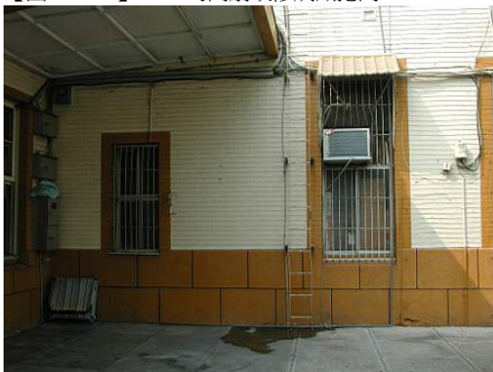
【圖 4-12-46】102R 的窗扇從室內封住並從室外安裝鐵窗
