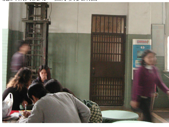
【圖 4-12-45】102R 的門扇裝設預鑄鐵門
