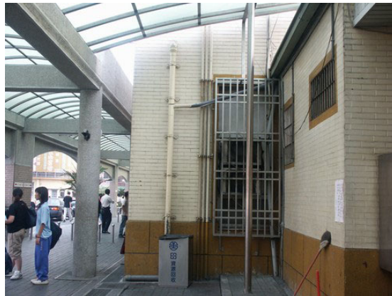
【圖 4-12-41】108R 窗洞以從室內封住，室外則安裝了鐵窗
