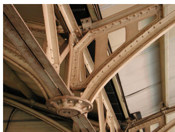
【圖 4-11-50】嘉義火車站第一月台短向框架下方燈座搭節點。
