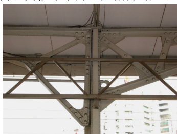
【圖 4-11-53】嘉義火車站第二月台長向梁架與柱身搭接方式。
