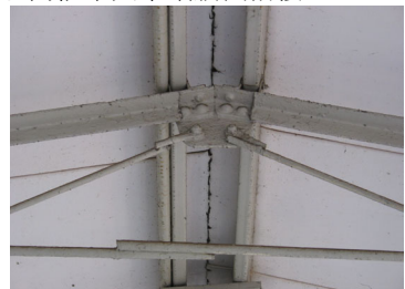
【圖 4-11-54】嘉義火車站第二月台短向框架上方中央節點板。
