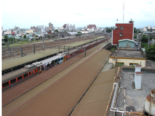
【圖 4-11-46】嘉義火車站月台雨棚北側屋面現況。
