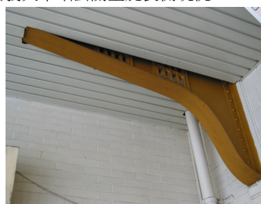
【圖 4-11-21】嘉義火車站玄關土底裏面之鋼骨懸臂構材現況。
