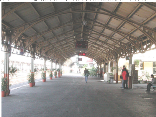
【圖 4-11-47】嘉義火車站第一月台短向 wc 型框架現況。
