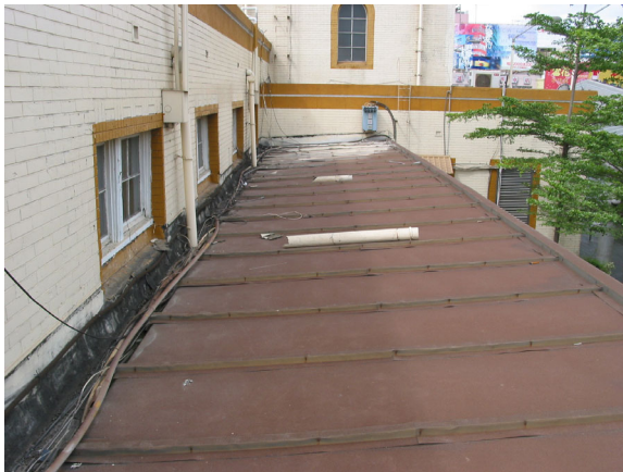
【圖 4-11-24】嘉義火車站三等候車室前側之土底上方現況。
