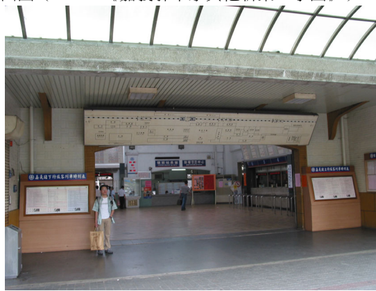
【圖 4-11-18】嘉義火車站玄關土底裏側現況。
