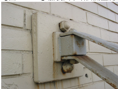
【圖 4-11-19】嘉義火車站玄關土底上方之「煉鐵製鈎金物」與壁體搭接現況。
