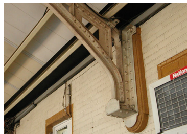
【圖 4-11-51】嘉義火車站第一月台短向框架與車站牆面搭接。
