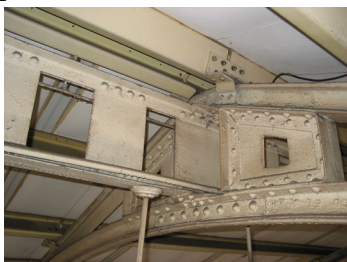
【圖 4-11-49】嘉義火車站第一月台短向框架上方中央節點板。
