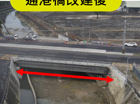
通港橋改建後
