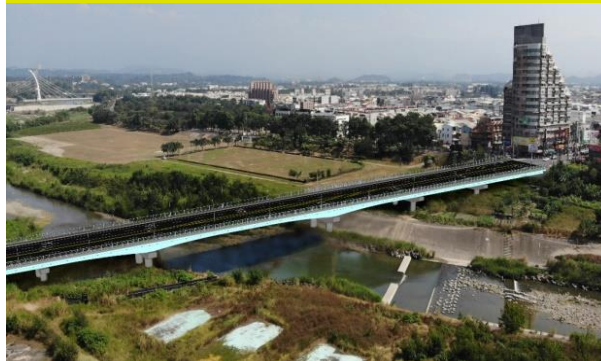
軍輝橋(施工中)
