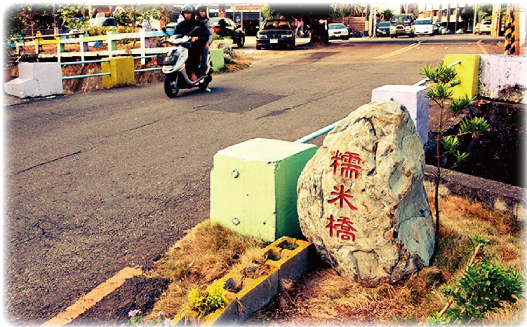
**嘉義市**宣信街北側與舊道爺圳的交會處，有座「芳草橋」，其橋寬二米，採用「砌石工法」打造，先將糯米、赤糖與蚵殼灰拌成黏著劑，以人工把一塊塊的砂岩組合建成，故稱糯米橋。芳草橋是道將圳上最古老的橋，迄今已高齡140多歲，仍承載許多世代更迭的歷史足跡。
