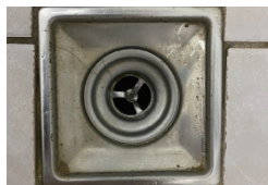
❌ Lỗ thoát nước chưa có biện pháp phòng ngừa sự xâm nhập của vật trung gian truyền bệnh
