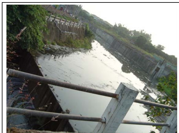
中央大排水溝
