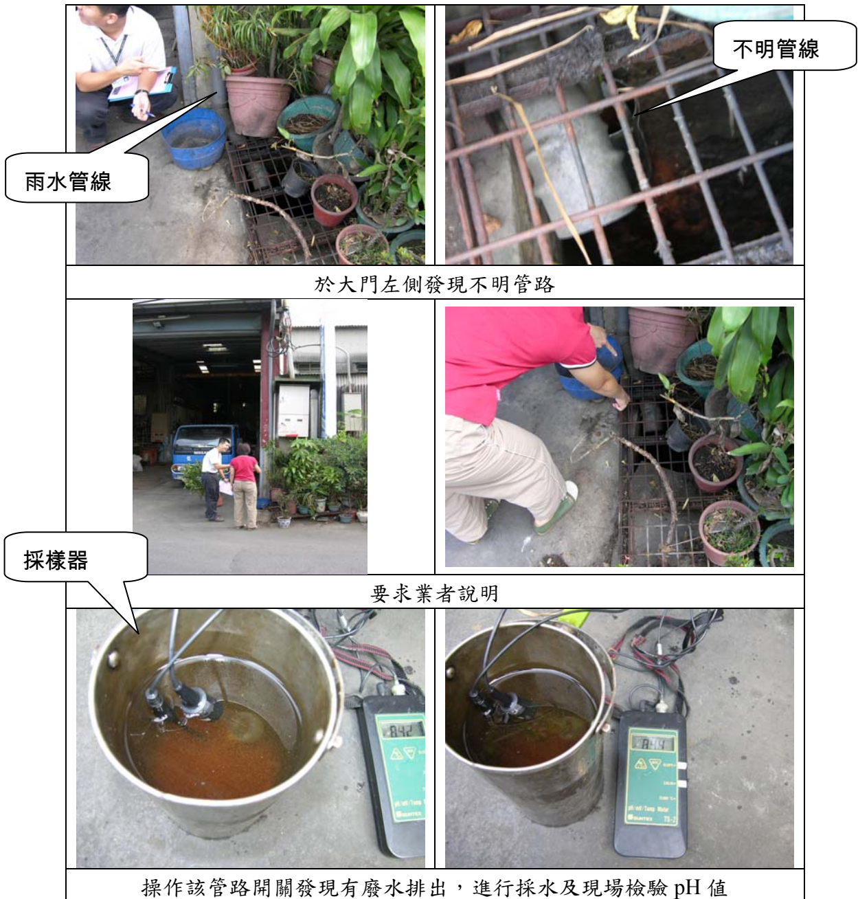
圖 3.3.1-8、查獲志鏢股份有限公司不明管線
