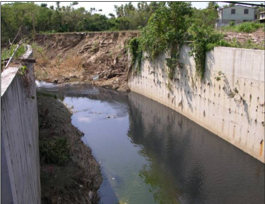
圖 1.1-5、規劃水質淨化處理場址-場址一照片(北區排水近匯流處)
