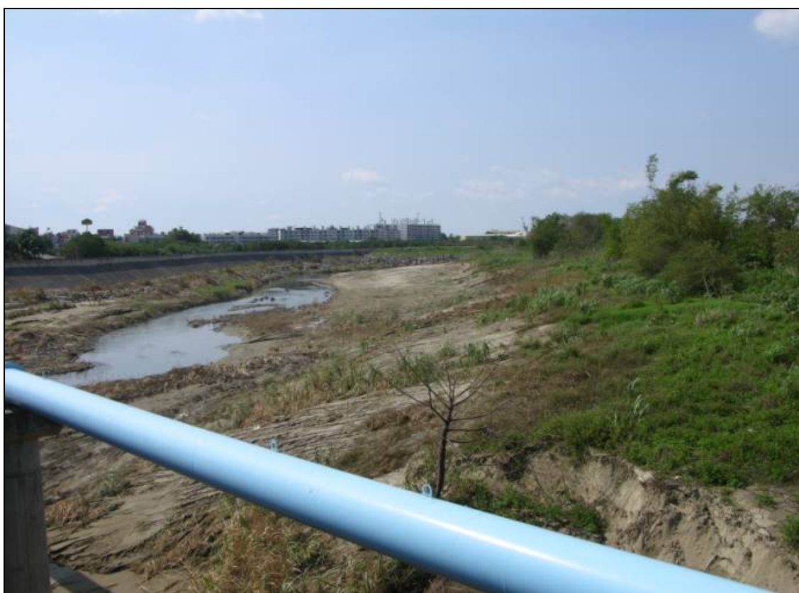
圖 1.1-7、規劃水質淨化處理場址-場址二照片(華興橋北方處靠河川土地)
