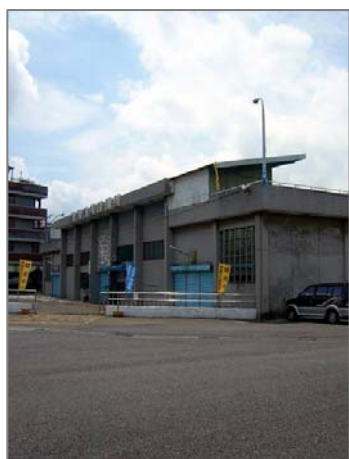
游泳池外觀現況
