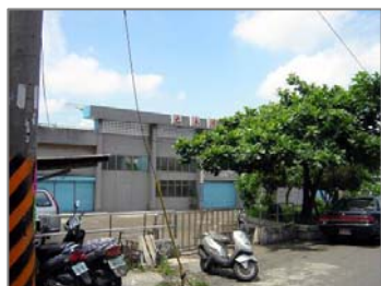
游泳池外觀現況
