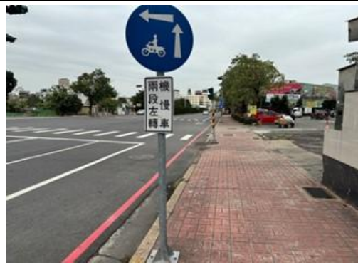
標誌設置造成淨高不足
