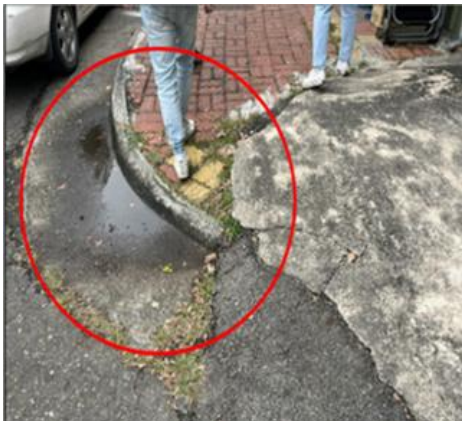
路緣斜坡與道路銜接處具高低落差
