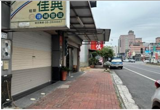
商家廣告造成淨高不足2.1m
