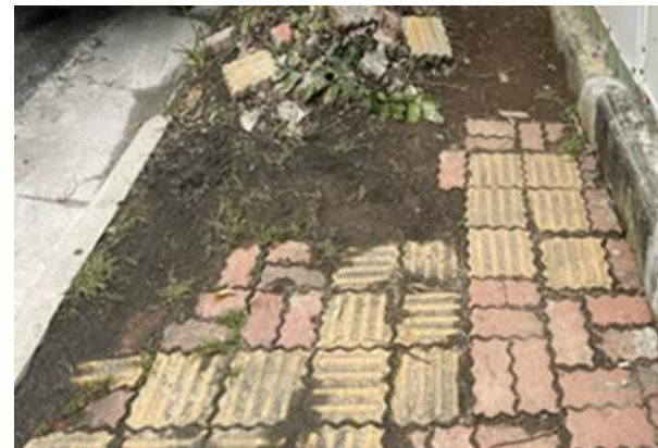
鋪面破損、龜裂
