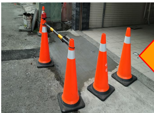
側溝修復完成
