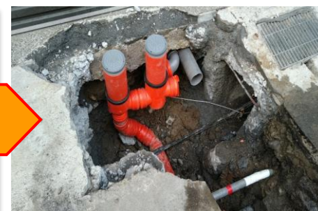
匯流設施(清除孔)組立 完成
