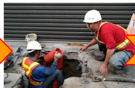
匯流設施(清除孔)組立 安裝
