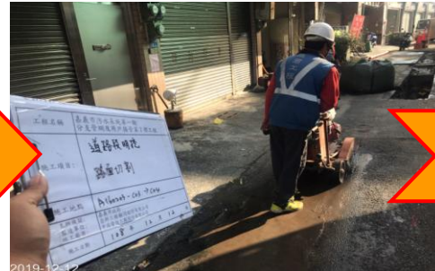
開挖路面切割
