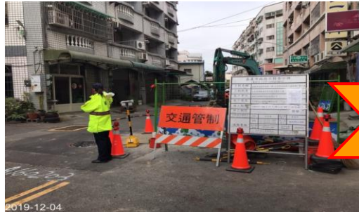
佈設交維設施
