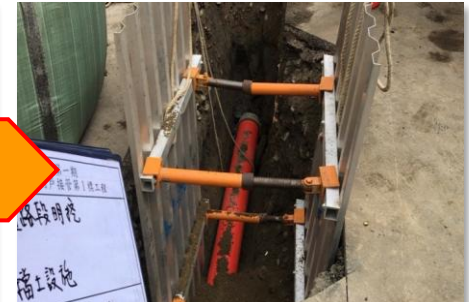
擋土設施及埋設管線
