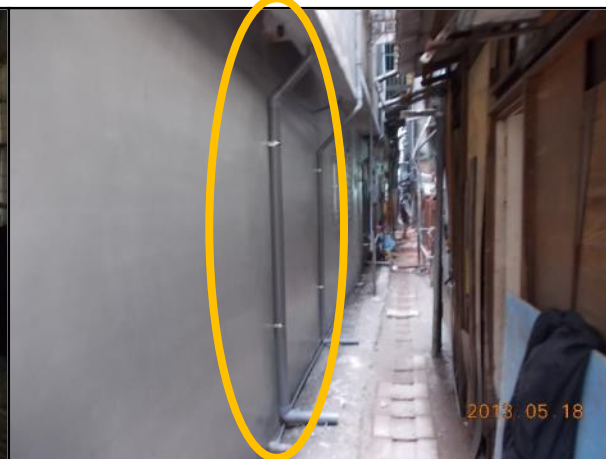
裸露排水管改善後參考相片
