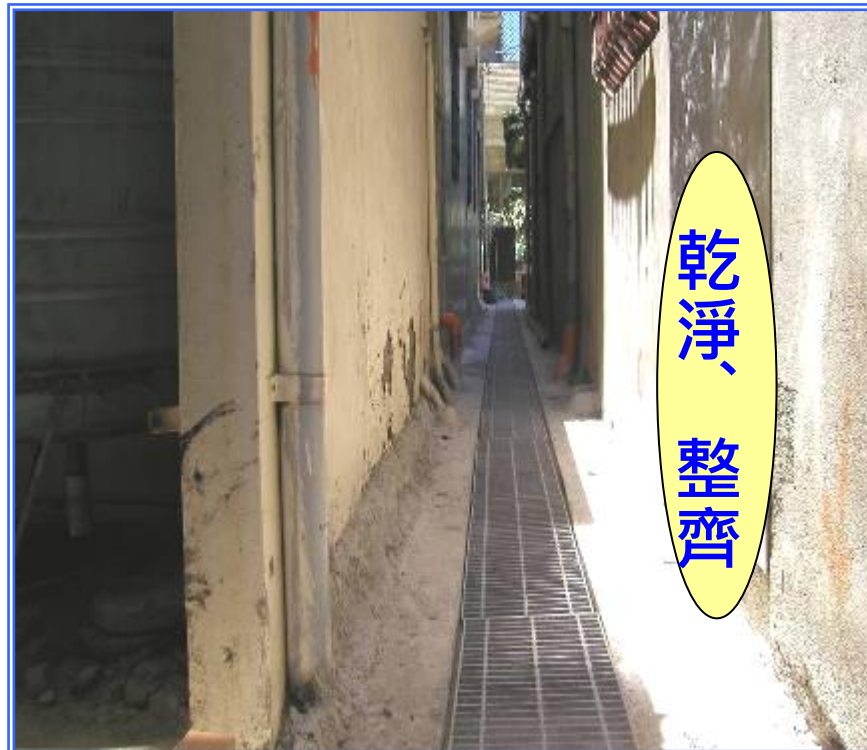
後巷用戶接管施工後
