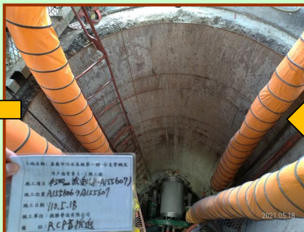
5. 管線推進作業
