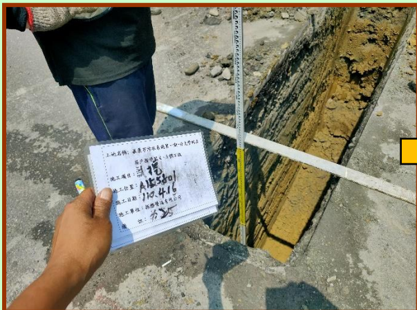
1. 管線試挖作業
