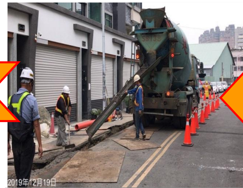
CLSM混凝土澆置
