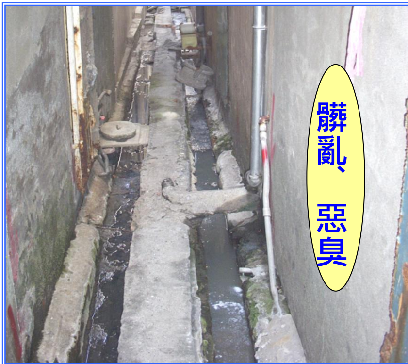
後巷用戶接管施工前
