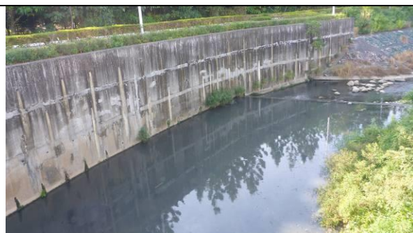
W3 上游左岸牆面排水孔有棕沙燕棲息 (拍攝日期：107年12月4日)
