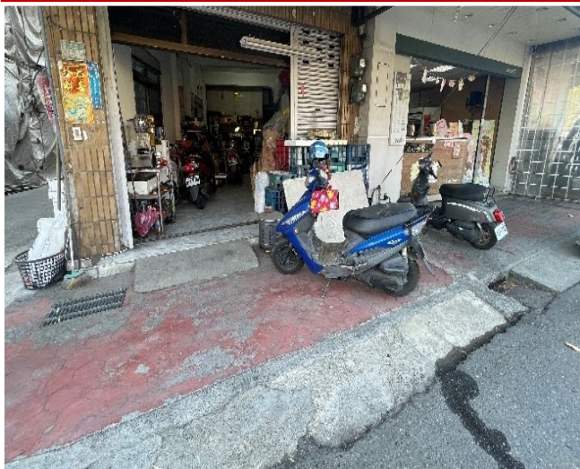
既有人行道老舊、破損
