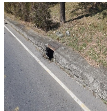
➤ 側溝損壞
