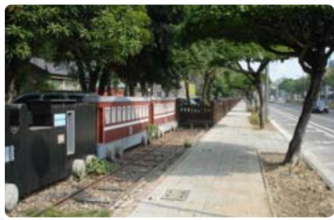
■ 民生西路人行道改善工程
