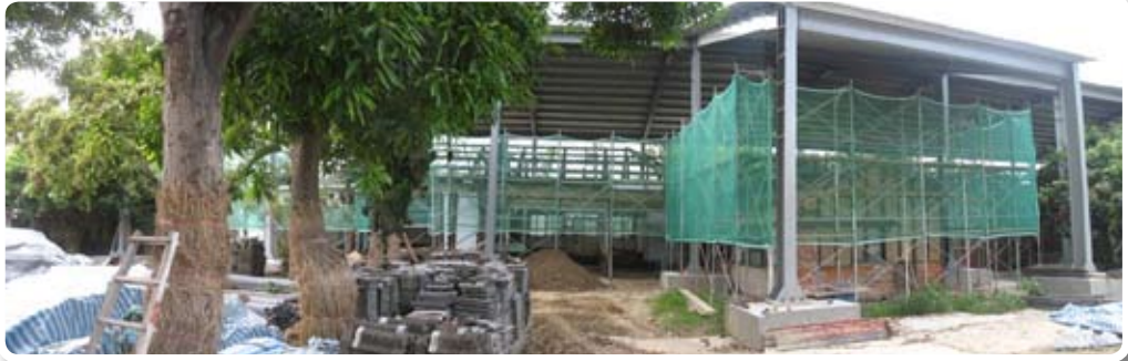
綜合行政區整修工程
