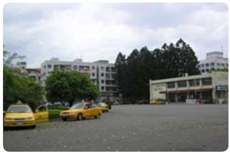
北門車站施工前
