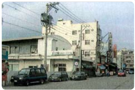
嘉基保健醫療大樓施工前
