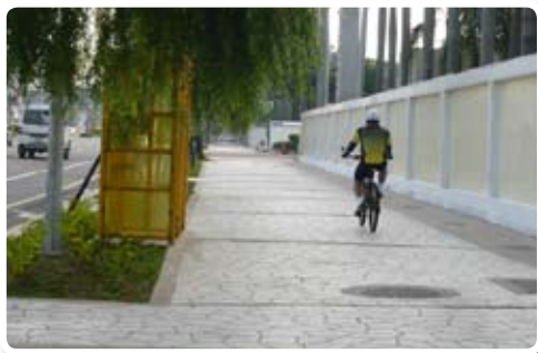
■ 垂楊路人行道改善工程
