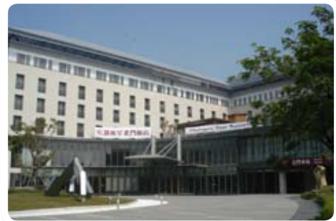
北門車站施工後
