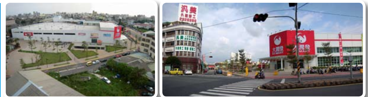
嘉義大潤發工程施工後
