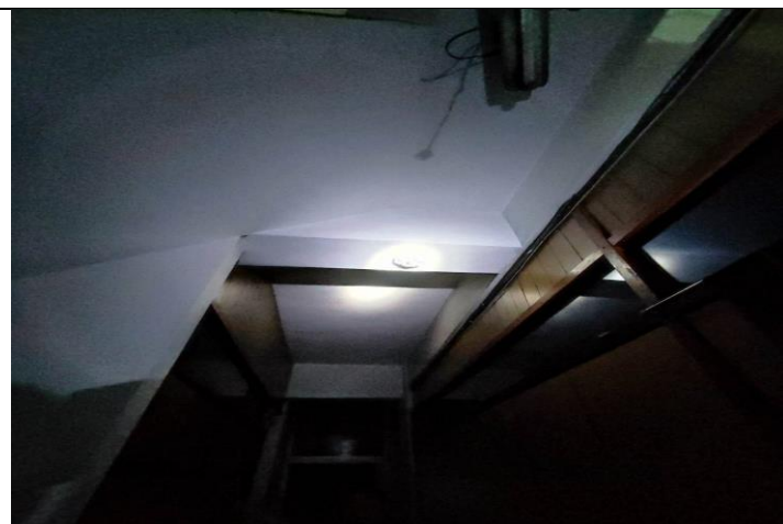
2樓住警器安裝位置
