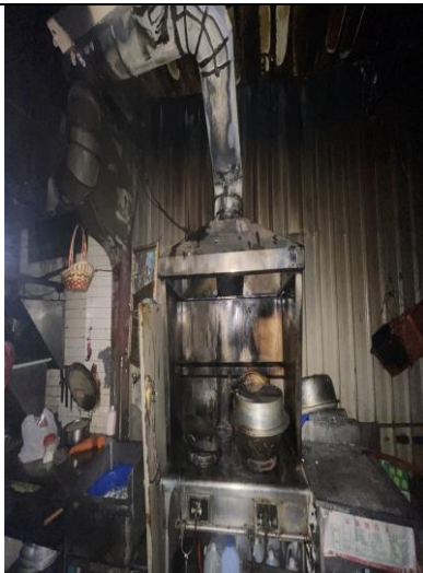
起火處鍋具燒焦情形
