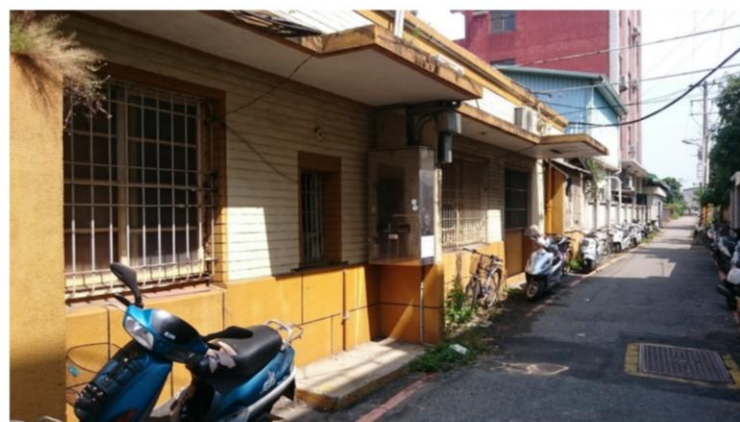
↑ 站內辦公室圍牆現況照片
