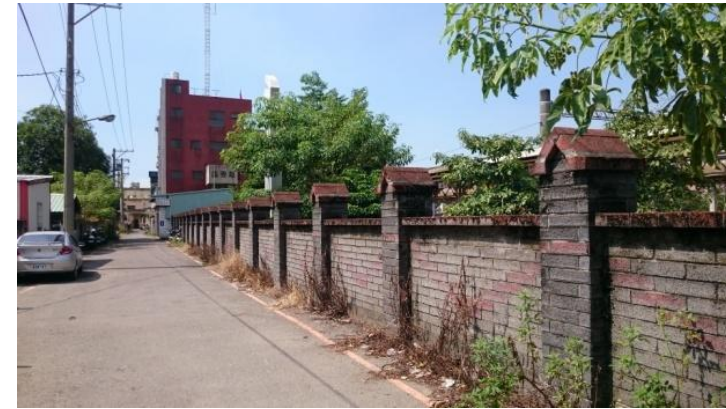
↑西側站內圍牆現況
