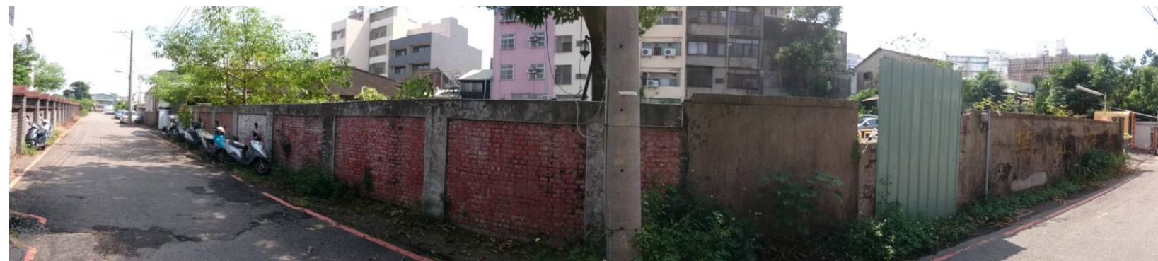
↑東側停車場圍牆現況
