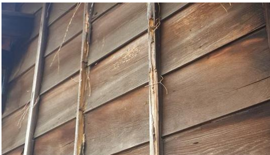
雨淋板外部裝修
