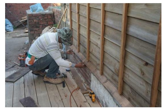
說明：雨淋板與混凝土基座之外牆收邊修繕・損壞處切除置換。
