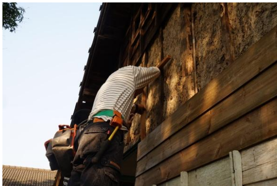
說明：將損壞的雨淋板、壓條依原貌仿作
