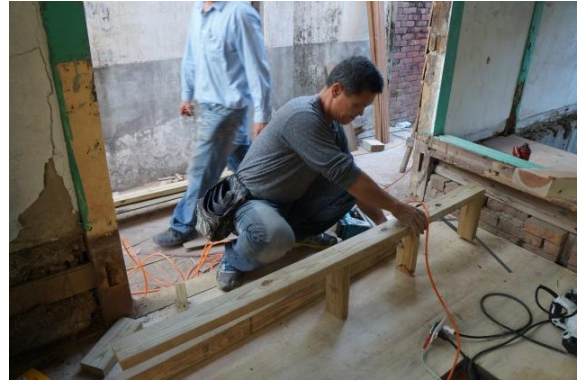
說明：居間窗台重新修補置換。
