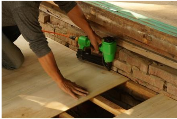
說明：居間改下沉式木地板・木構架修繕・木地板新作。
