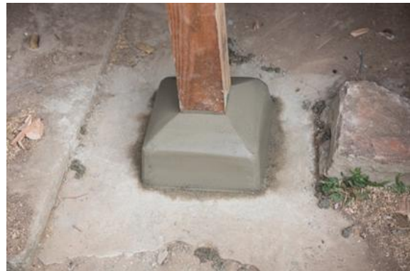
說明(左)：地坪高程重新放樣・前後門廊水泥地坪新作。(右)：緣側木基座以水泥新作。
