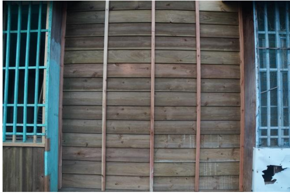
說明：將 17 號與 19 號連接之牆面重新修繕。
