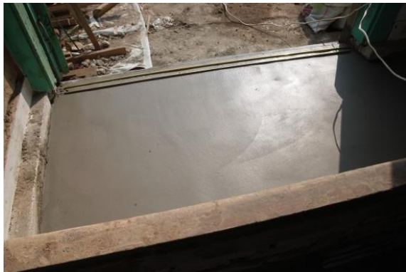
說明(左)：地坪高程重新放樣・前後門廊水泥地坪新作。(右)：緣側木基座以水泥新作。
