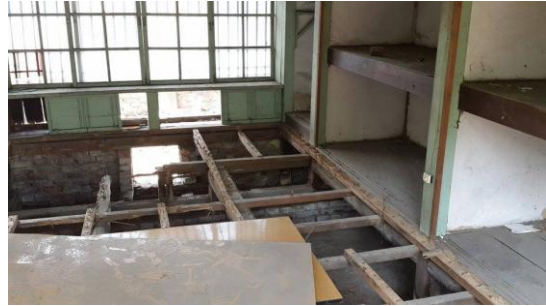
室內環境現況
