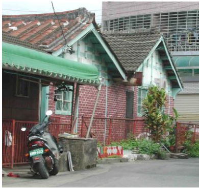
照片 5-1-11 ↑ 現有舊建築
