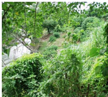
圖 4-23 後庄排水邊坡
