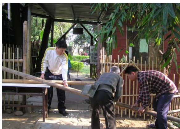
圖 8-7 損壞的竹材拆除換新。
