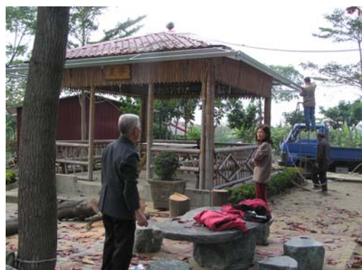
圖 8-3. 鐵工加裝耐久材質屋簷
