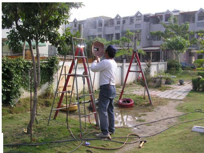
圖 8-10 鐵工提高鞦韆，解決低窪積
