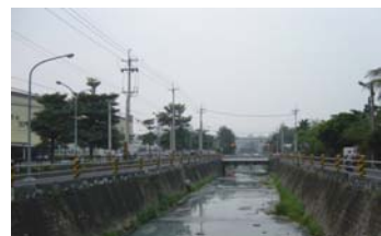
排水河道環境現況
