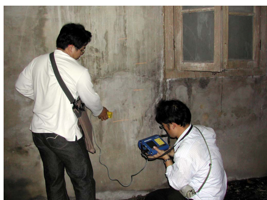
【照片 4-1-1】水錶室東側牆體檢測現況
