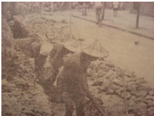
【照片 2-31】1950 挖掘路面鋪設電信用陶管（發展中的台灣電信 1964）
