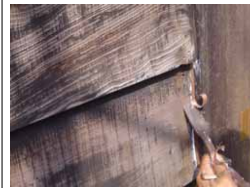
相 4-62 EPOXY 填入並以刨刀修正 94.11.18
