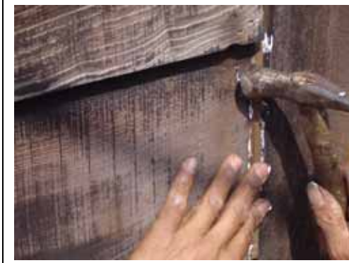
相 4-60 與柱面縫隙填縫 94.11.18
