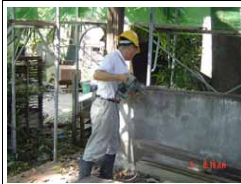
相 4-42 手編工廠磚牆台度打除 94.7.21
