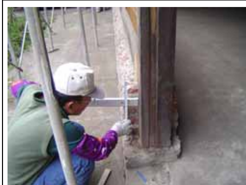
相 4-46 磚牆台度粉刷層打除 94.7.9
