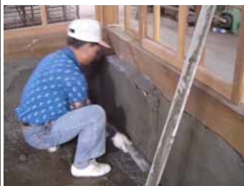
相 4-49 重新水泥砂漿粉刷施作 94.7.22
