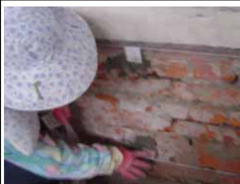
相 4-47 磚牆檢視修補 94.7.12
