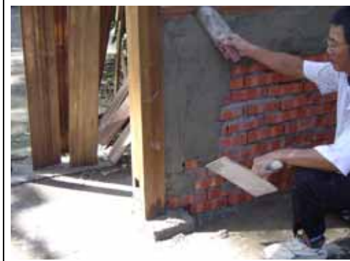
相 4-44 手編工廠磚牆台度粉刷 94.7.22
