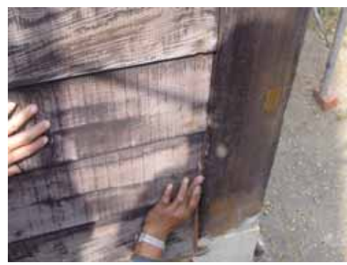
相 4-63 縫隙填縫完成 94.11.18
